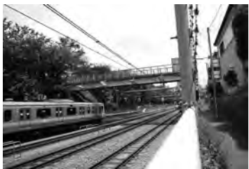
▲ 東中野跨線橋
